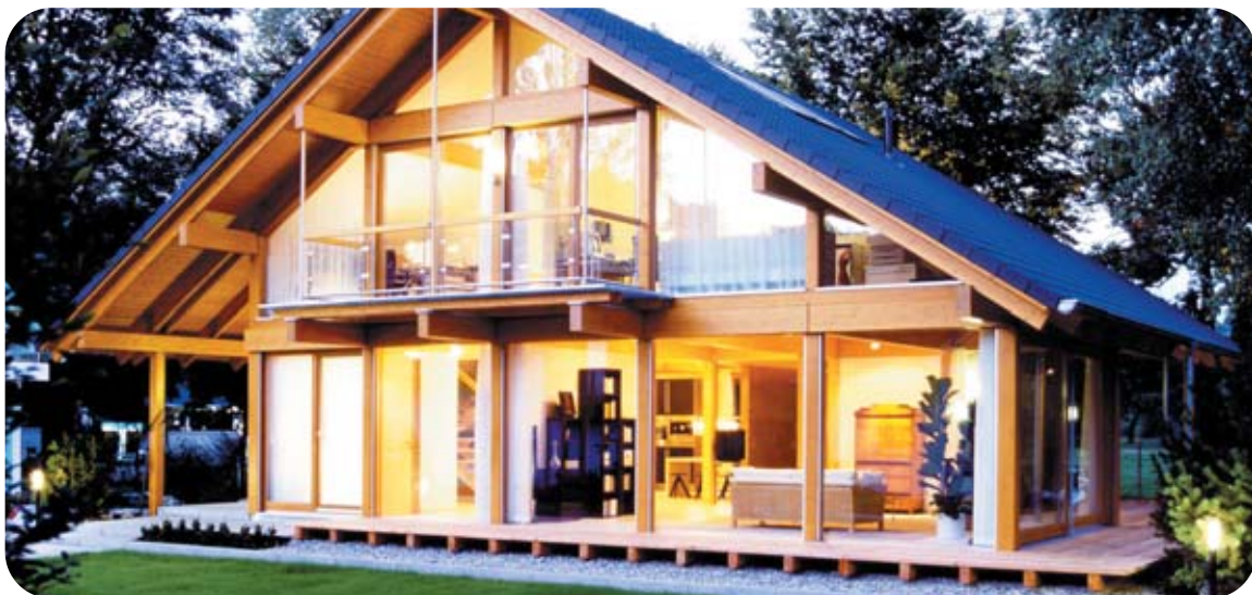
패시브 하우스란 첨단 단열공법을 이용해 에너지의 낭비를 최소화한 주택을 가리킨다. 사진제공_ germanhomes
